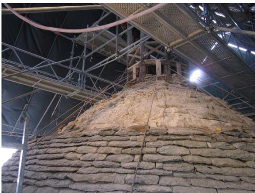
Avec la couverture en laves, le toit se confond presque avec les murs par la couleur mais aussi par la nature et la disposition du matériau.
