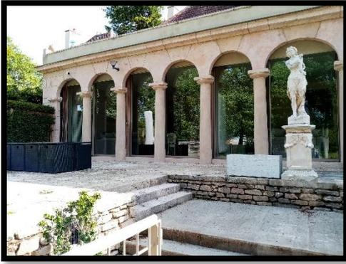
Pour ces travaux, les coloris d'origine sont conservés, les ouvrages de pierre de taille sont réparés. Les toitures et les menuiseries extérieures et fermetures font l'objet de travaux d'entretien. La lucarne côté parc, disparue lors de l'explosion de 1944, est restituée.
